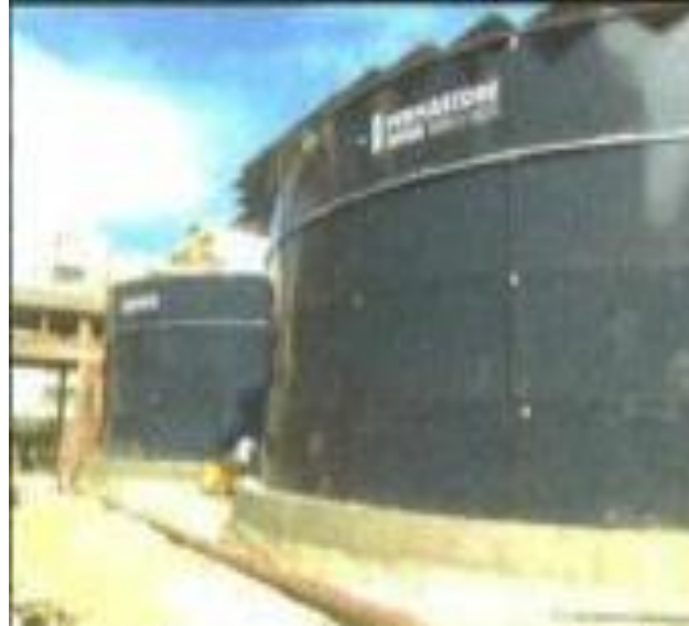
عملية إنشاء رافع بمدينة ٦ أكتوبر شاطيء النخيل
