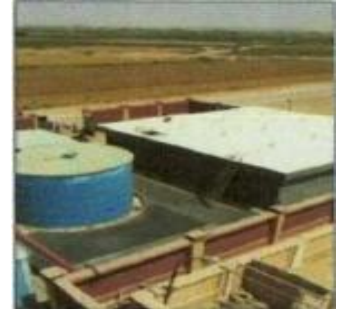
عملية إنشاء خزان سعة ١٠٠٠ لتر ومبنى إداري سكني (معمل) بقرية الزهور
