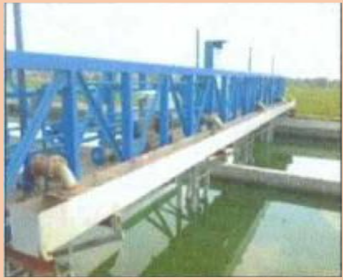
عملية إنشاء محطة المنشية ٢ بأبيس
